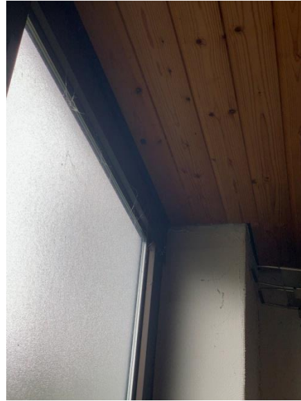
Abb. 7: Keller mit Spinnweben, ohne Kotspuren von Fledermäusen
