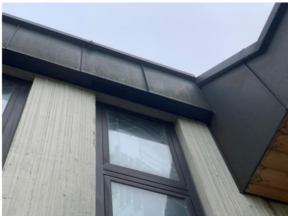
Abb. 4: Fassade ohne erkennbare Einflugmöglichkeiten oder Kotspuren
