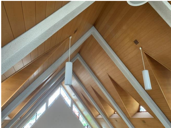
Abb. 2: Blick auf das vollausgebaute Dach
