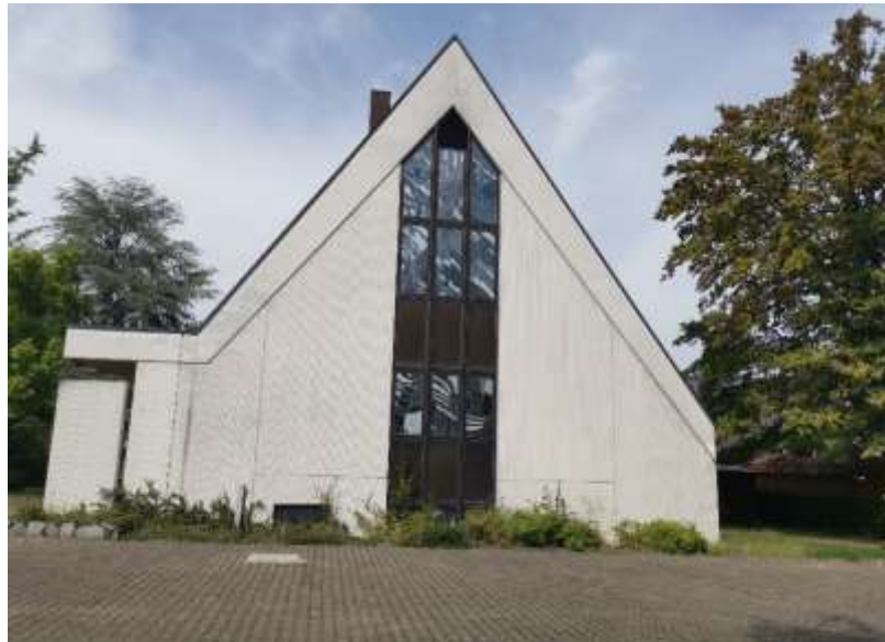
Kirchengebäude mit Fenstern, Lamellen und Spitzdach (Blick von Süden)
