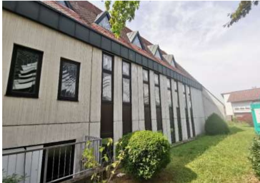
Gebäudefassade (Ostseite) mit geschlossenen Fenstern (Blick von Südosten)
