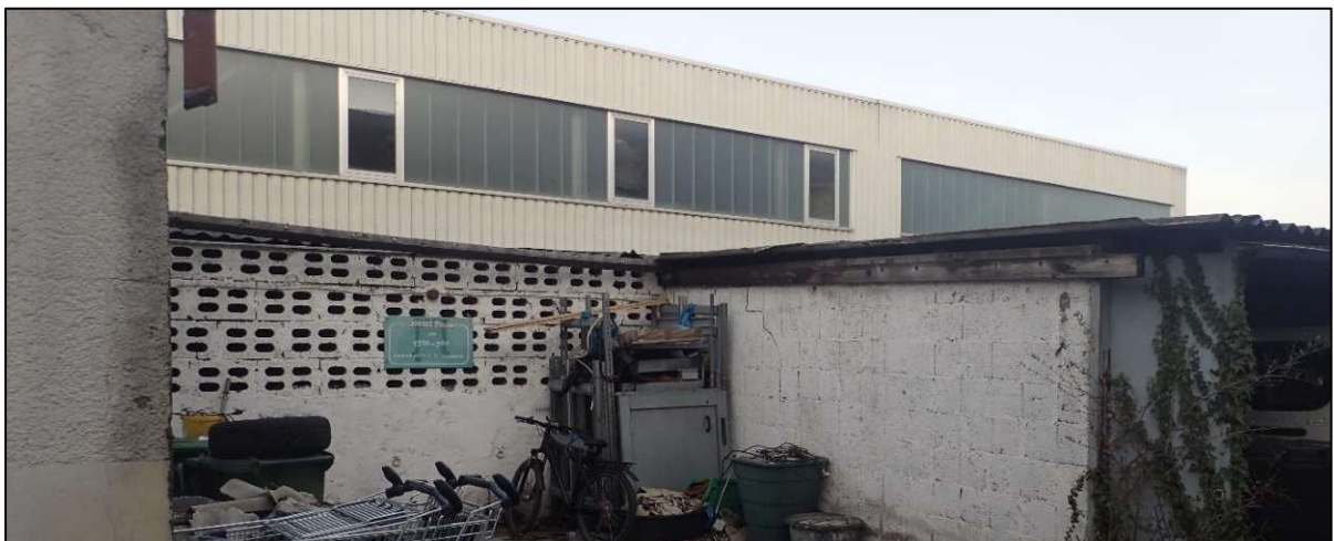
Abbildung 11: Hofwand mit seitlich verbauten Hohlbausteinen mit einer Eignung als Bruthabitat für nischen- und gebäudebrütende Vogelarten.
