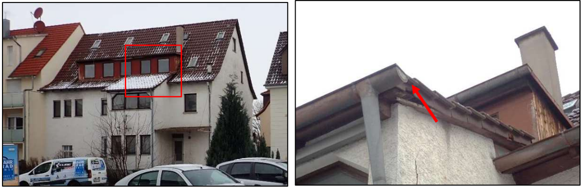
Abbildung 9: Bereich mit Schädelleiste am Dach des Gebäudes „Wilhelmstraße 9“ (linkes Bild) und Detailansicht der Schädelleiste (rechtes Bild).
