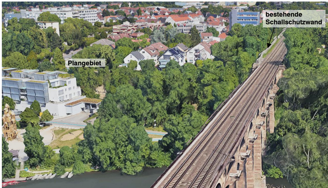
Abbildung 12: Schrägluftbild, Blick von Westen, Quelle: google earth, GeoBasis-DE/BKG (©2009), abgerufen am 20.02.2025
