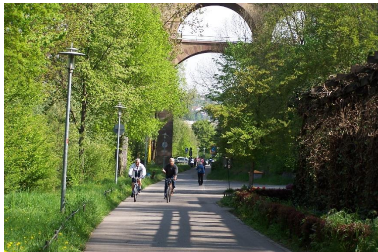
Abb. 13: Radweg am Viadukt (Presseamt)
