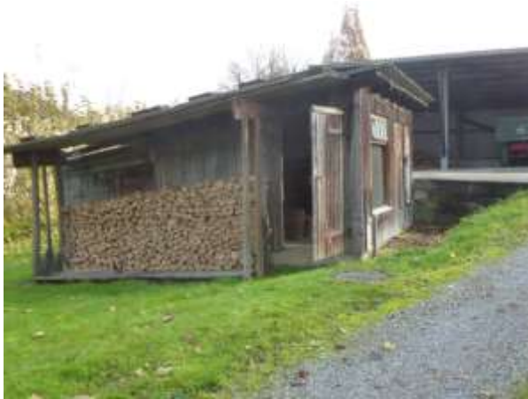
Abb. 13: Offener Holzschuppen (dient der Lagerung von Holz usw.)
