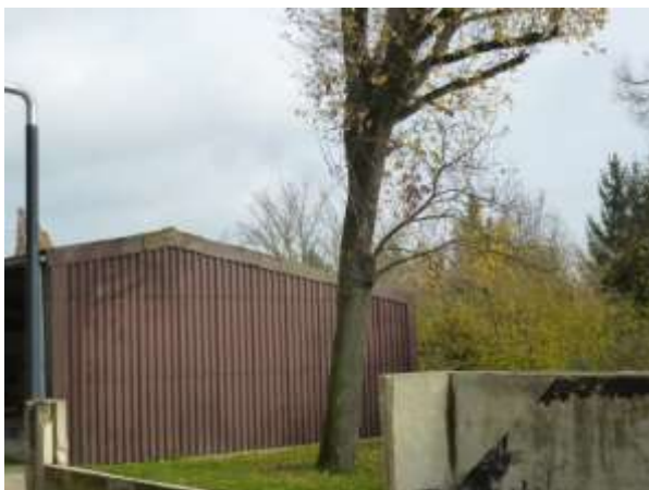
Abb. 11: Überdachter Stellplatz mit sehr glatten Wänden und Randprofil im Dachbereich.
