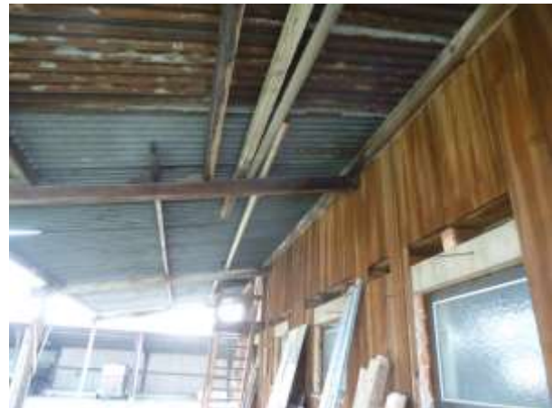
Abb. 6: Überdachung an der Nordseite der Scheune ohne Reste von Vogelnestern.
