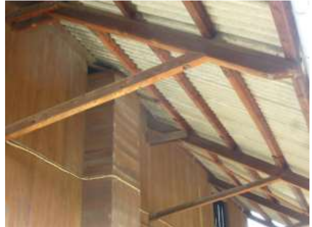
Abb. 8: Überdachung an der Ostseite der Scheune ohne Reste von Vogelnestern.
