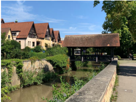
Foto 19: Metter – Historische Brücke
