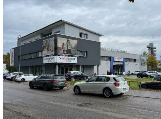
Foto 26: Talstraße – Bebauung mit Gewerbecharakter
