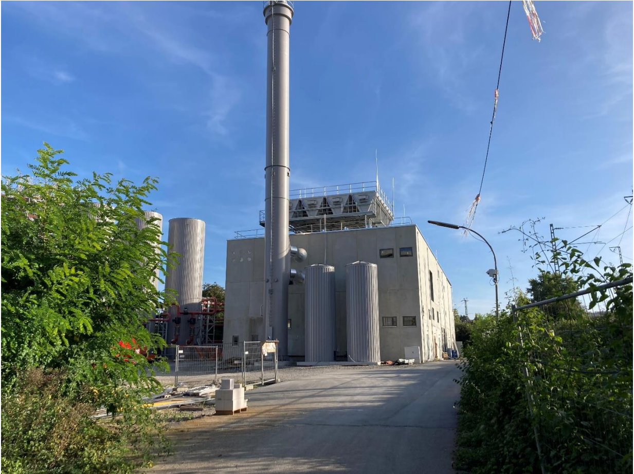
Foto: Energiezentrale, Stadtwerke Bietigheim-Bissingen
