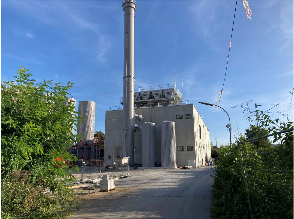
Foto: Energiezentrale, Stadtwerke Bietigheim-Bissingen
