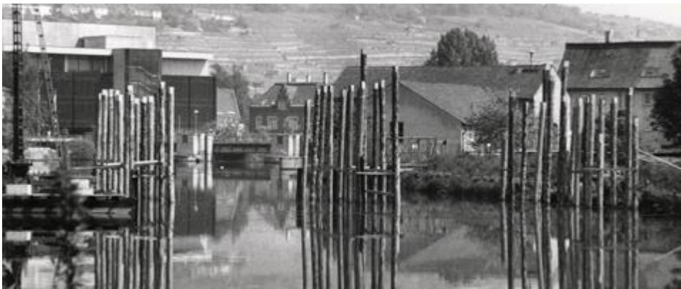
Pfahlgründung für die Auwiesenbrücke, im Hintergrund links das Kronenzentrum und die Enzbrücke. Fotograf: unbekannt.
