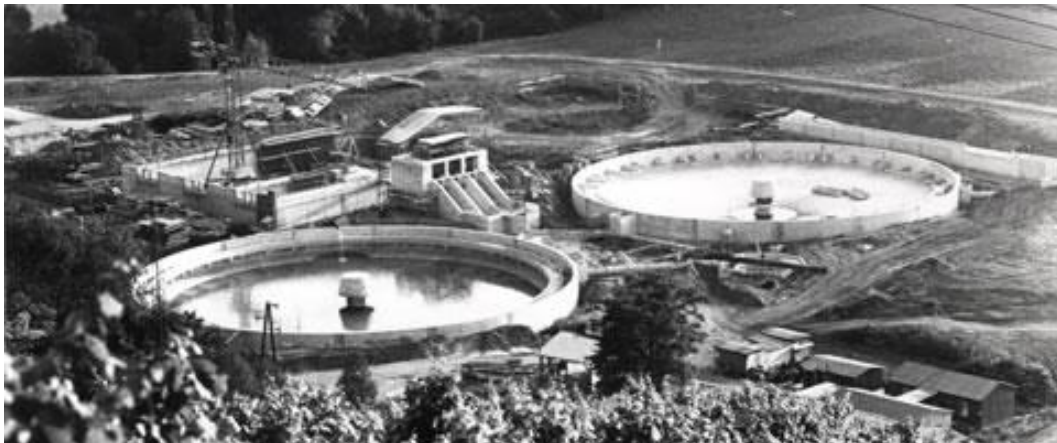
Die Sammelkläranlage Nesselwörth in den Grünwiesen. Das Bild zeigt den Stand der Bauarbeiten im Sommer 74. Fotograf: unbekannt.
