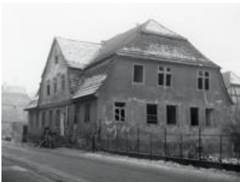
Der "Kleine Lorcher Klosterhof" kurz vor Abbruch 1963. Fotograf: unbekannt.
