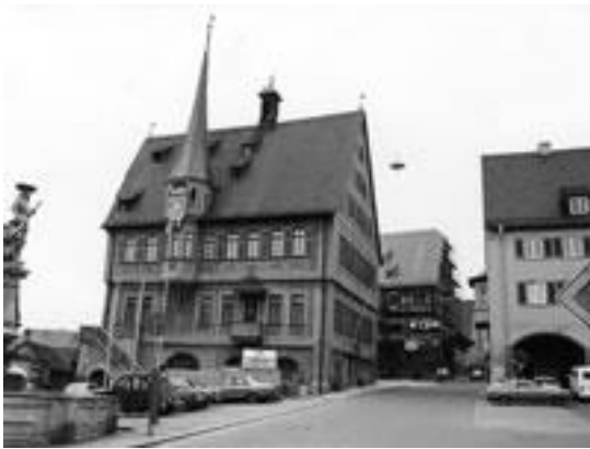
Das Bietigheimer Rathaus nach der Sanierung. Fotograf: unbekannt.
