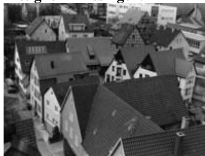
Blick von Kirchturm auf das Sanierungsgebiet Schwätzgässle mit den Neubauten an der Stadtmauer. Fotograf: unbekannt.
