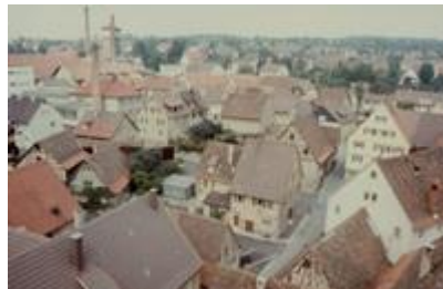
Luftbild Bereich Schwätzgässle/Pfarrstraße/Turmstraße vor der Sanierung. Aufnahme: Liegenschaftsamt Stadt Bietigheim-Bissingen.
