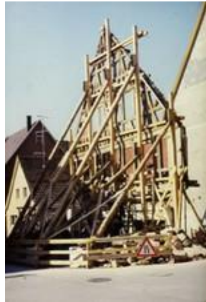
Während der Sanierung im März 1982: nur die Fachwerkfassade bleibt stehen. Fotograf: Erwin Mickler.
