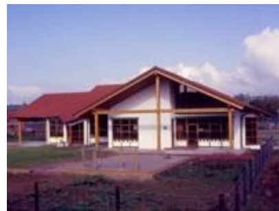
Der neue Kindergarten im Bissinger Neubaugebiet Entenäcker. Fotograf: unbekannt.
